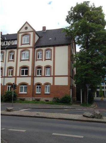
saniertes Wohnobjekt Kreuzberggring 22
