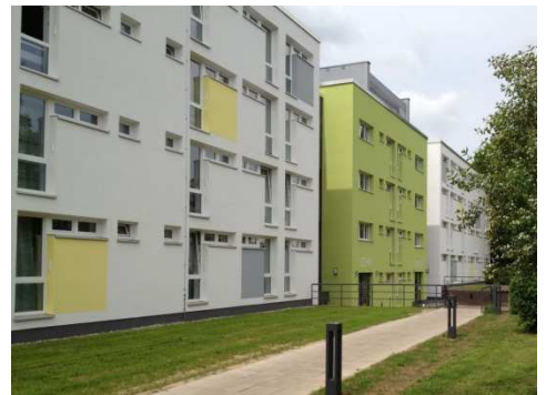
Wohnheim „Rosenbachweg 10-12“ nach der Modernisierung
