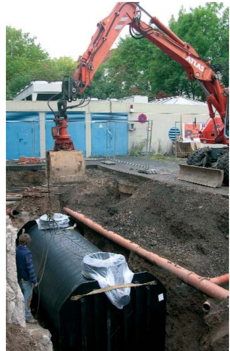
Hinter den Kulissen ist der Umbau der Zentralmensa bereits in vollem Gange
